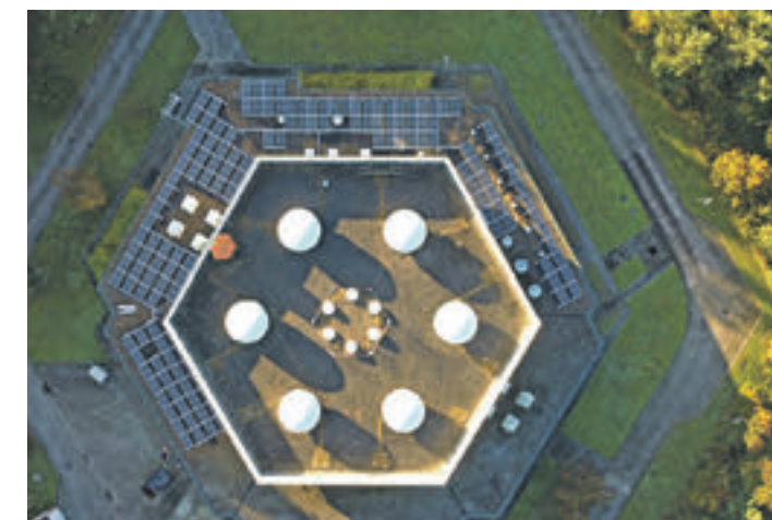
Aus der Vogelperspektive ist die Belegung der Dachfläche mit Solarmodulen gut zu erkennen.
