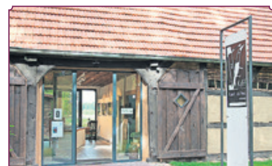
Licht durchfließt die umgebaute Scheune.
