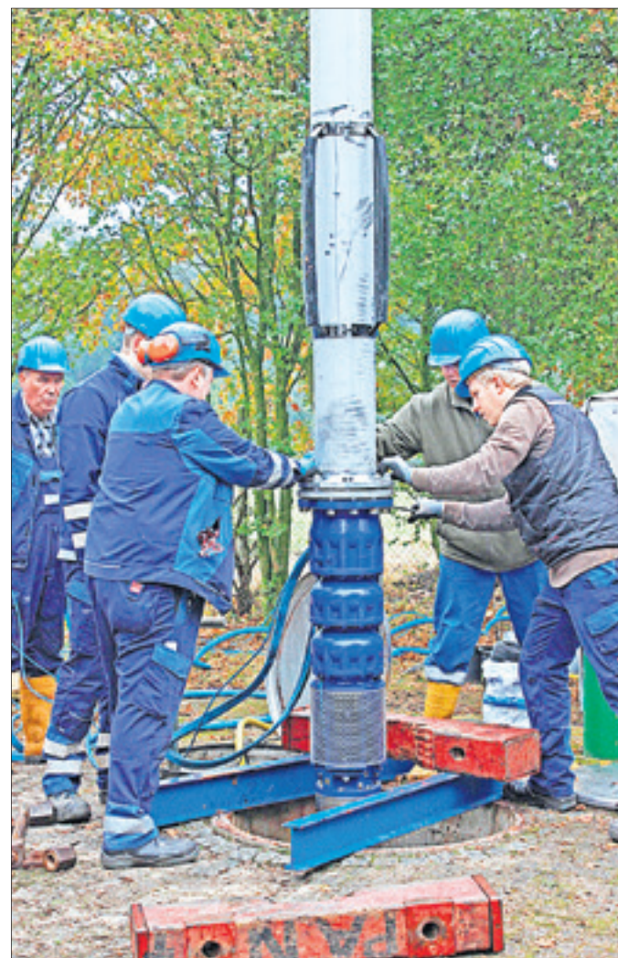
Mitte Oktober waren die Fachleute am Wasserwerk Panzenberg am Brunnen 5 im Einsatz.
