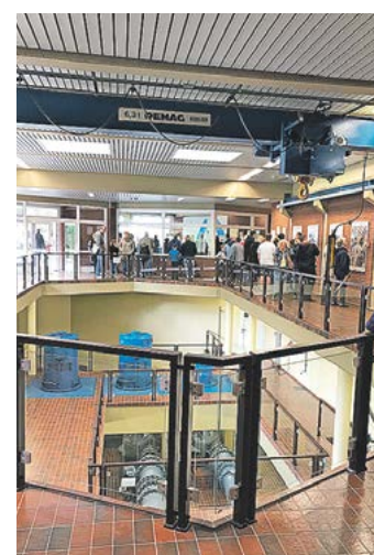
Mehrere Stockwerke gab es im Wasserwerk Panzenberg zu erkunden.
