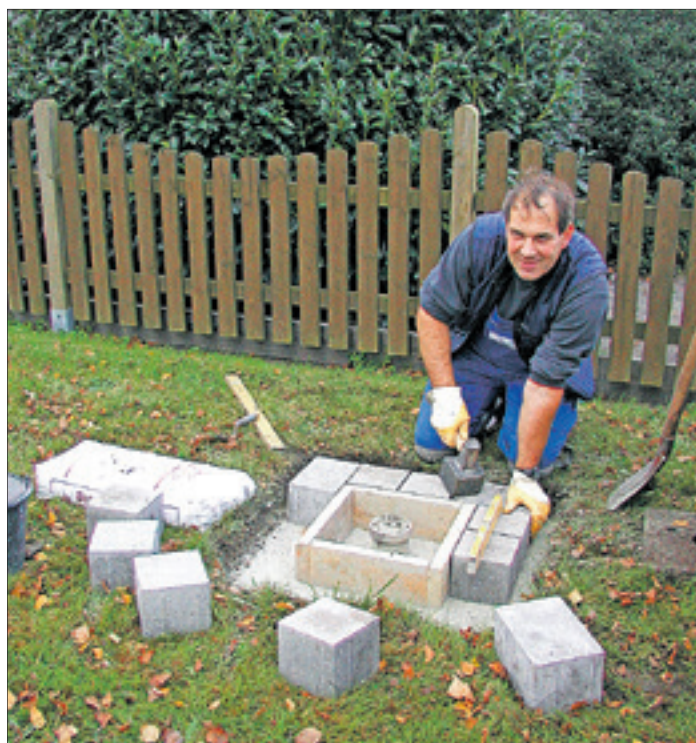
Marko Bertram sorgt hier in Ottersberg-Bahnhof dafür, dass die Schieber künftig besser zu sehen und damit geschützt sind.
