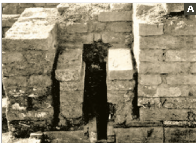
Wasseranlagen im Indus bei Mohenjo-Daro (heute Pakistan): Wassertoilette (A), Wasserleitungen (B) und Brunnen (C).
