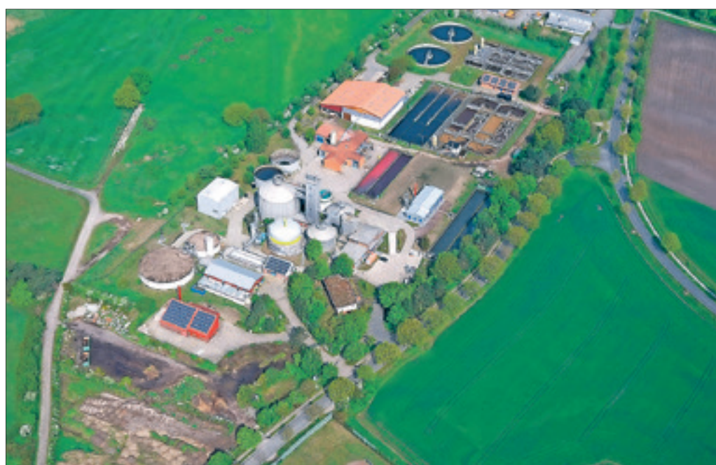
Aus der Vogelperspektive sind alle Stationen der Verdener Kläranlage zu erkennen.
