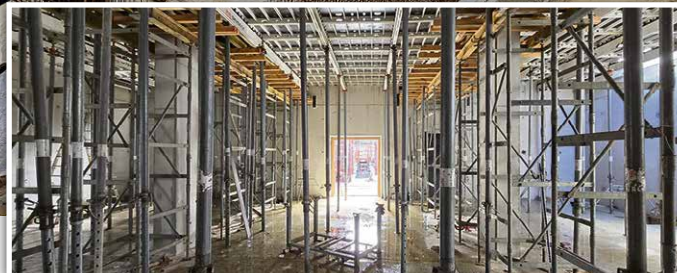
Etliche Pfeiler sichern den Baufortschritt.
