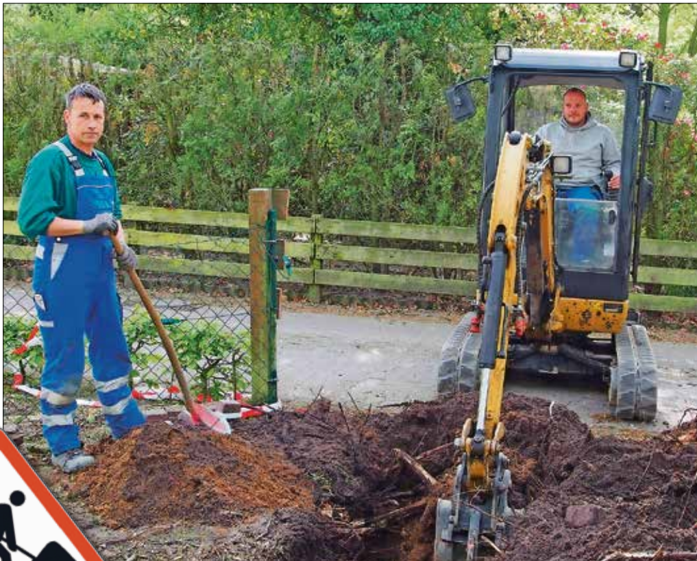
Sowohl große Technik als auch solide Handarbeit ist beim Arbeiten an Hausanschlüssen erforderlich, hier sind Jörg Bergling und Tobias Lindhorst (r.) im Einsatz.
