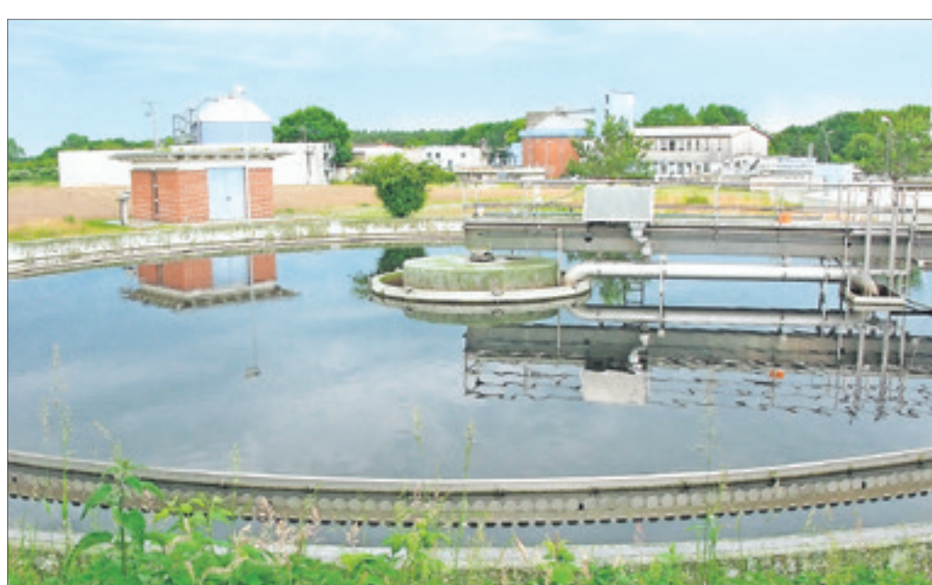
Das Herz der Abwasserreinigung ist die Achimer Kläranlage. Nach der letzten Stufe im Nachklärbecken (vorn) geht das saubere Wasser zurück in die Natur.
