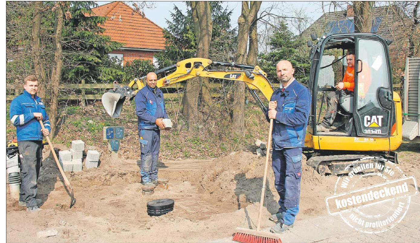
Die vier neuen Mitarbeiter des Bautrupps, fürs Foto auf einer Baustelle in Völkersen: Kim Lukas Lühning, Safet Krasniqi, Roman Rybalskiy und Dennis Gerstner (v. l.). Foto: SPREE-PR/Galda
