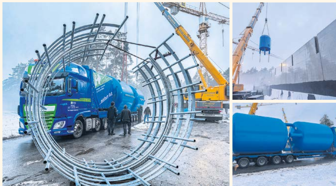
Schwertransporter brachten die insgesamt acht Filterkessel Anfang Januar auf die Baustelle am Goldbornweg 24 in Kirchlinteln-Kükenmoor.
