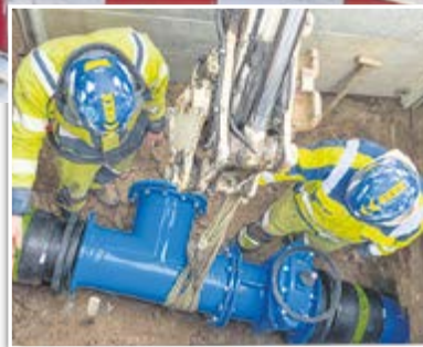
Hier verbinden zwei Mitarbeiter des TV Verden das neueste Teilstück mit der Haupttransportleitung an der Hauptstraße.
