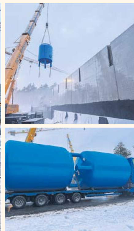
Per Kran wurden die Filterkessel ins Innere des neuen Wasserwerkes gehoben.
