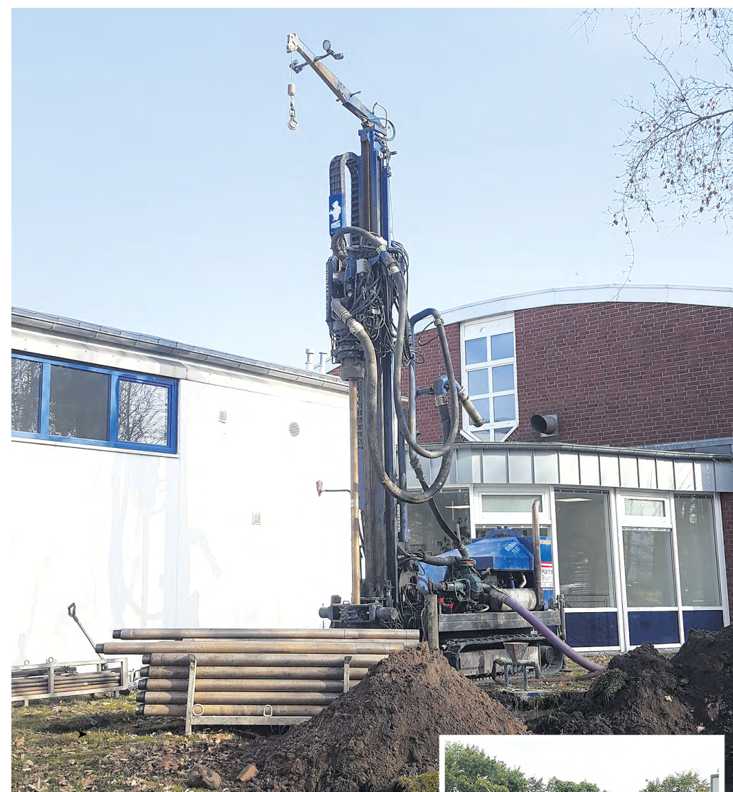
▲ Großes Bohrergerät rückte an, um die Erdsonden in den Untergrund zu verlegen.
